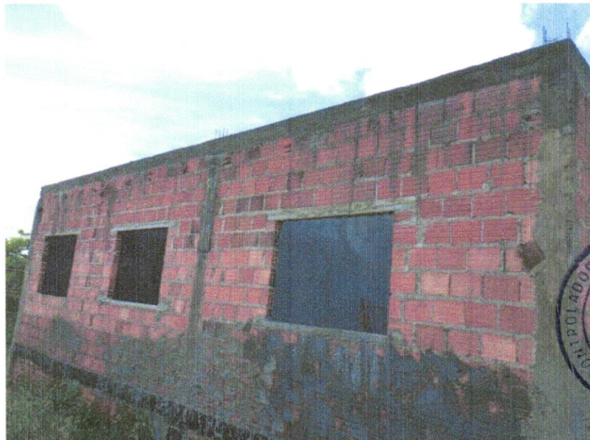
FOTO 04 - (COMPOSIÇÃO REPRESENTATIVA) EXECUÇÃO DE ESTRUTURAS DE CONCRETO ARMADO, PARA EDIFICAÇÃO HABITACIONAL UNIFAMILIAR TÉRREA (CASA EM EMPREENDIMENTOS), FCK = 25 MPA. AF_01/2017
