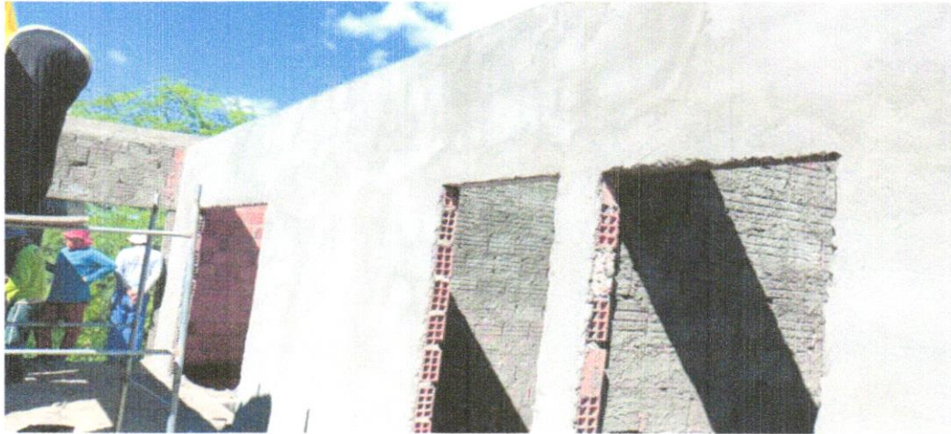
FOTO 05 – CHAPISCO APLICADO EM ALVENARIAS E ESTRUTURAS DE CONCRETO INTERNAS, COM COLHER DE PEDREIRO. ARGAMASSA TRAÇO 1:3 COM PREPARO EM BETONEIRA 400L. AF_06/2014 E MASSA ÚNICA, PARA RECEBIMENTO DE PINTURA, EM ARGAMASSA TRAÇO 1:2:8, PREPARO MANUAL, APLICADA MANUALMENTE EM FACES INTERNAS DE PAREDES, ESPESSURA DE 10MM, COM EXECUÇÃO DE TALISCAS. AF_06/2014
